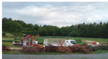
plateforme communale de broyage (Cursan)
